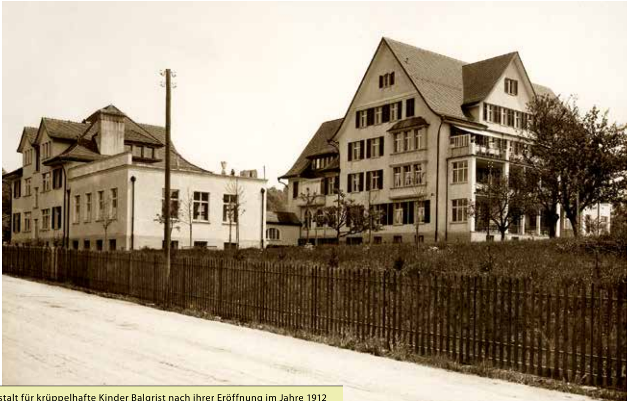
Die Anstalt für krüppelhafte Kinder Balgrist nach ihrer Eröffnung im Jahre 1912 (Sicht von Südwesten). Man beachte die offenen Veranden auf der rechten Seite des Hauptgebäudes (heute Altbau I). Auf der linken Seite das kleinere Poliklinikgebäude, das in der Zwischenzeit abgebrochen wurde.
